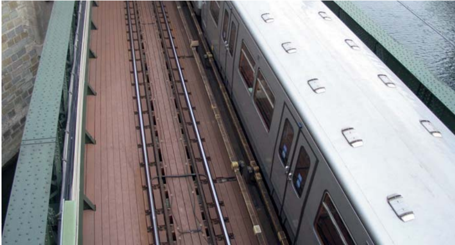
Abb. 3: FFU Kunstholz, Zollamtsbrücke der Wiener Linien
