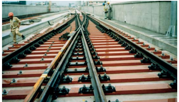
Abb. 8: FFU Kunstholz, Weiche auf Fester Fahrbahn, Japan
