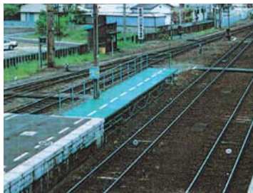
Verlängerung Bahnsteig Platform extension work
