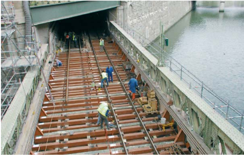
Zollamtsbrücke – U-Bahn Brücke (Wien/Österreich) Zollamtsbrücke – subway-bridge (Vienna/Austria)
