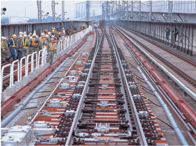
Takasaki #38 Weichenschwellen, die längsten in Japan (Kokuriku Shinkansen) Takasaki #38 switch sleeper, longest in Japan (Kokuriku Shinkansen)
