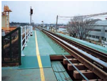
Gehweg auf Brücke Bridge sidewalk
